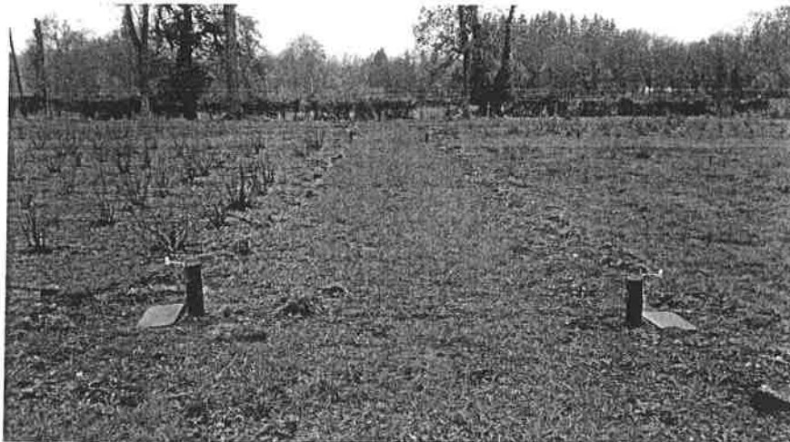
Tuyaux d'irrigation dans les parcelles de Ribes – novembre 2018
