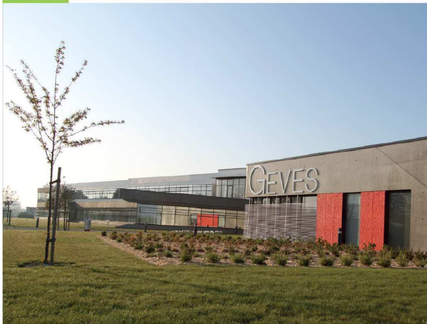
Le site du GEVES à Beaucouzé (49), regroupant le siège, la Station Nationale d'Essai de Semences et une partie du laboratoire BioGEVES
